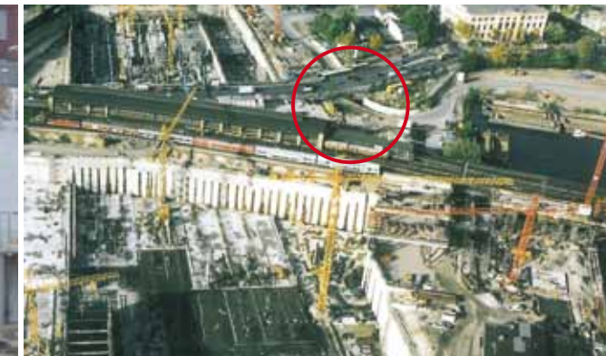
Baugrube S21 Hauptbahnhof, Berlin Das aus mehreren Teilbaugruben herzustellende Ingenieurbauwerk der S21 bindet ca. 18 m mit einer rückverankerten Sohle in den Baugrund ein (LP 2-6)
