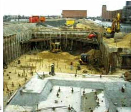
Pantaeinius-Haus, Hafencity Hamburg Planung der Baugrube neben dem Hafenbecken und des Teilabbruchs der „Neuen Kaianlage“ sowie deren Integration in das Tragwerkskonzept der Baugrubenumschließung (LP 3-5)
