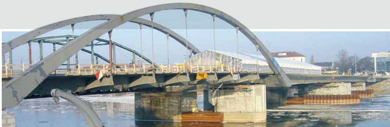
Stadtbrücke Frankfurt/Oder Errichtung der ca. 250 m langen neuen Brücke in Parallellage und nach Demontage der alten Brücke Querverschub in Endlage; Planung aller Unterbauten in Behelfs- und Endlage, der Stropfpieler und der Brückenverschiebkonstruktionen (LP 3-5)
