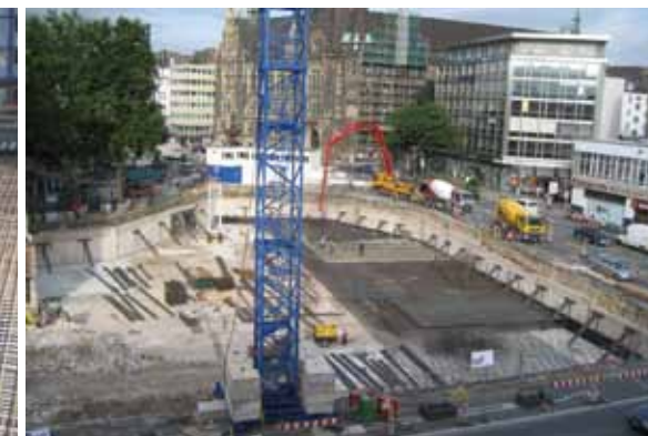
Einkaufszentrum, Wuppertal Tragwerksplanung für Abriss und Neubau eines Einkaufszentrums unter Nutzung des Bestandskellers zur Baugrubensicherung und der vorhandenen Gründungselemente für die neue Stützenstellung (LP 1-4/6)
