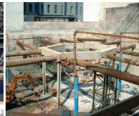
Kurfürstendamm, Berlin Wohn- und Geschäftshaus: Tragwerksplanung der Baugrube als innenliegende Steifenlösung mit Druckring (LP 3-5)
