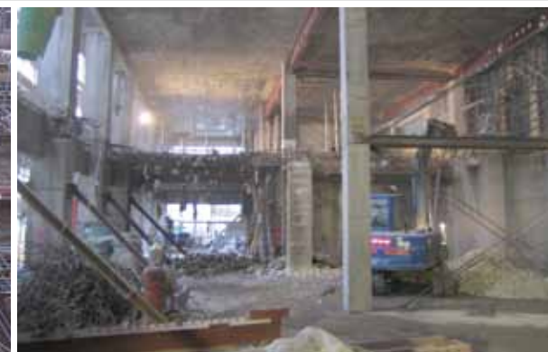
Berlininhaus, Alexanderplatz 1, Berlin Umbau des denkmalgeschützten Gebäudes vom UG bis zum 2. OG zu einem Einkaufszentrum durch Vergrößerung des vorhandenen Stützenrasters mittels Abfangkonstruktion in Stahlbeton- bzw. Stahlverbundbauweise im 3. OG (LP 1-6/8)
