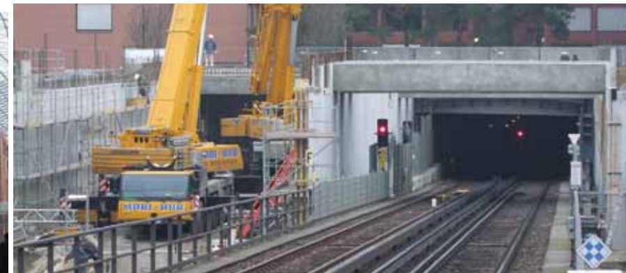
Mendelssohn-Bartholdy-Park, Berlin Tragwerksplanung der Baugrube und des Hochbaus für ein 7-geschossiges Wohnhaus über dem unterirdischen Fahrweg der U-Bahn am Potsdamer Platz (LP 1-5)
